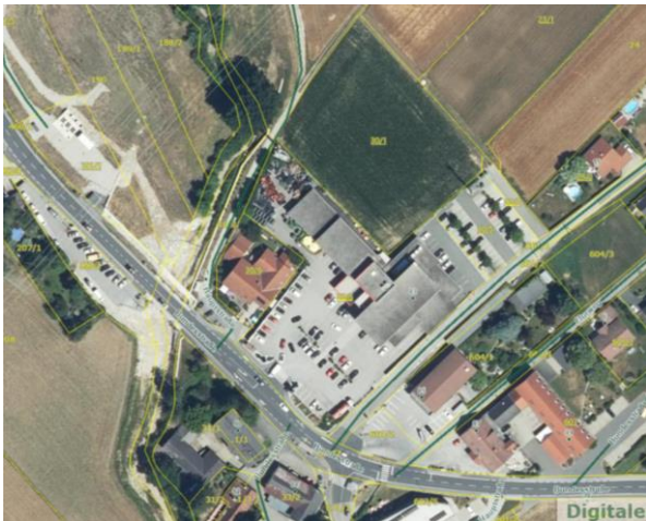
Abb. 1: Luftbild, Bereich Dörfla
