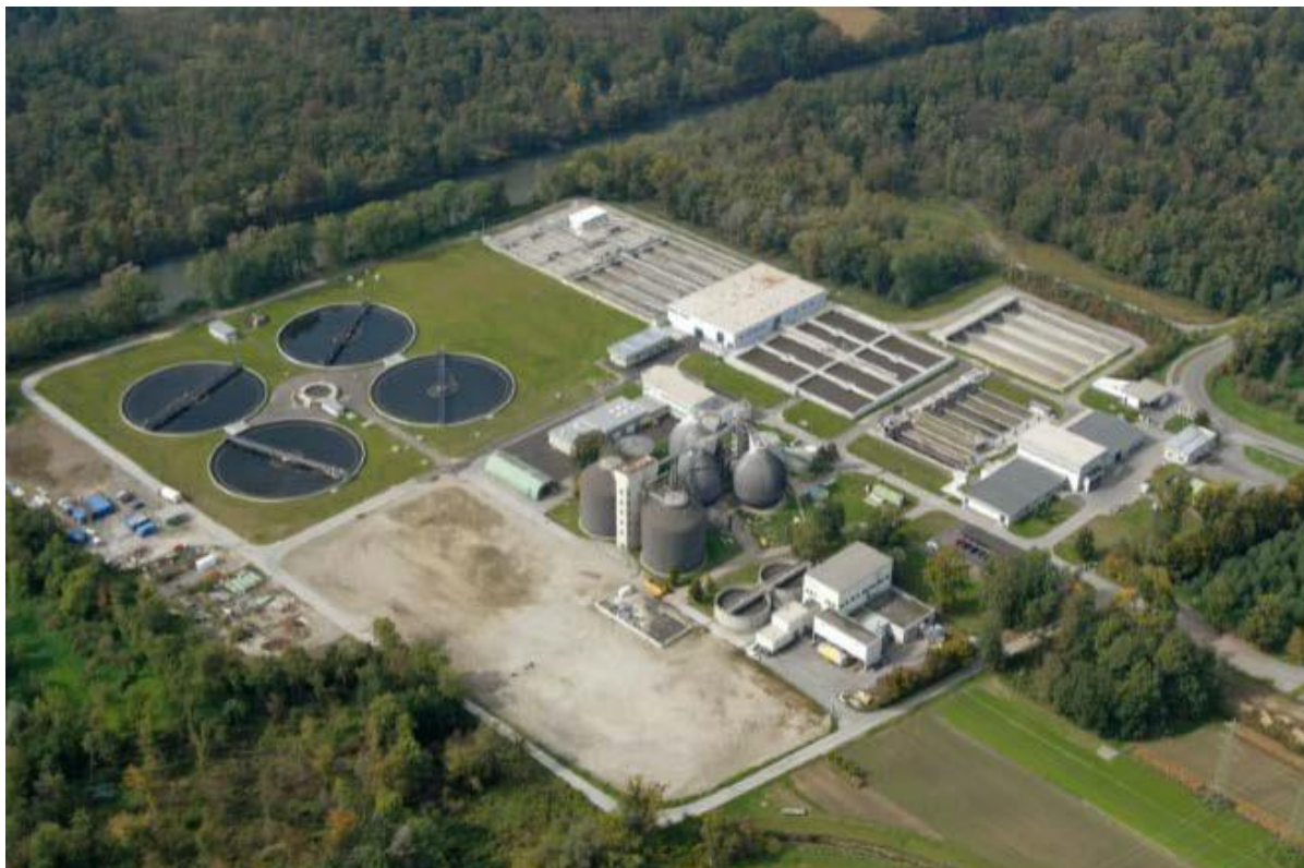
Abbildung 2: Ansicht der ARA Graz Gössendorf (Luftbild; Quelle: Holding Graz)
