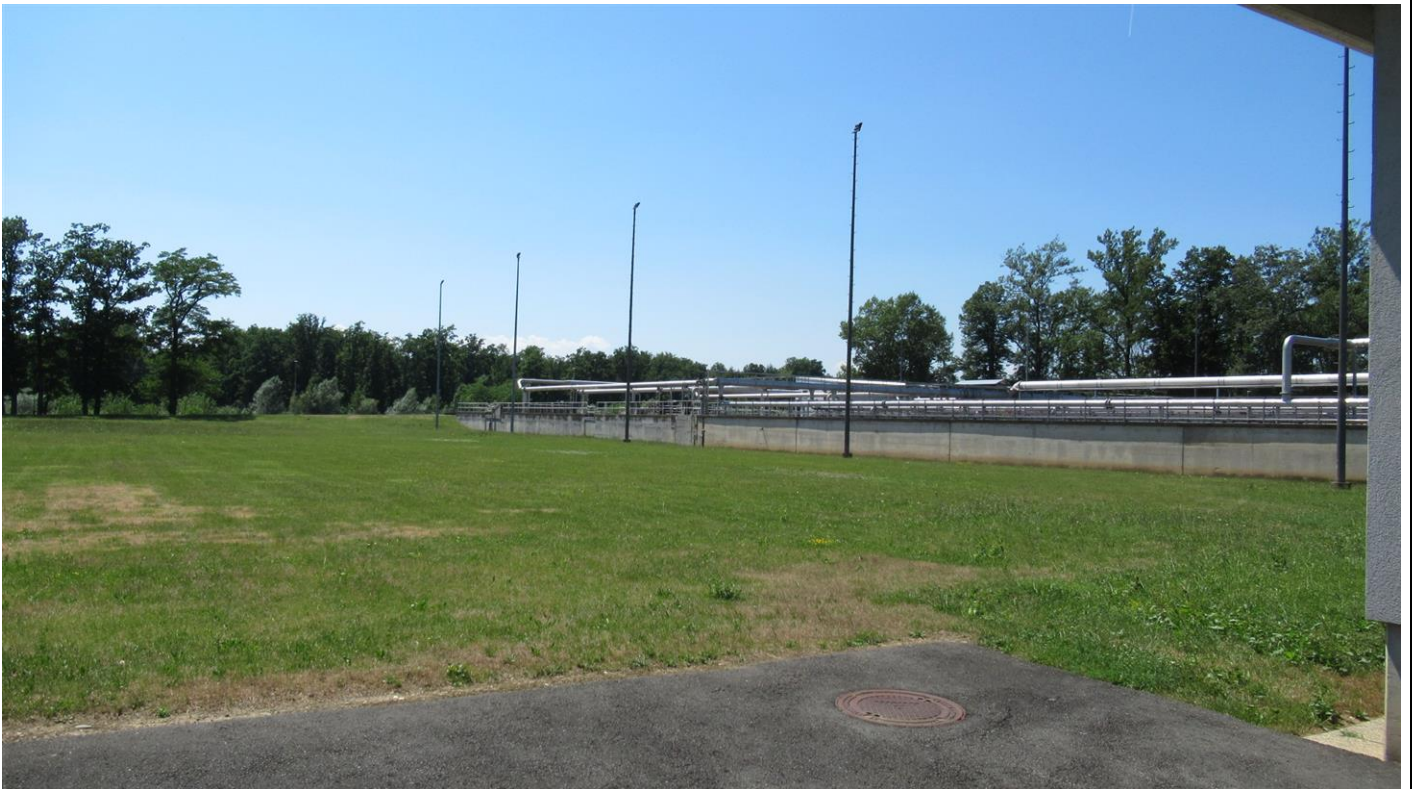
Lage des geplanten Belebungsbeckens, bestehende Belebungsbecken im Hintergrund (Blickrichtung Westen)
