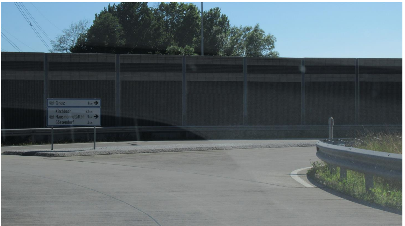
Kreisverkehr-Ausfahrt Richtung Gössendorf (Blickrichtung Süden)
