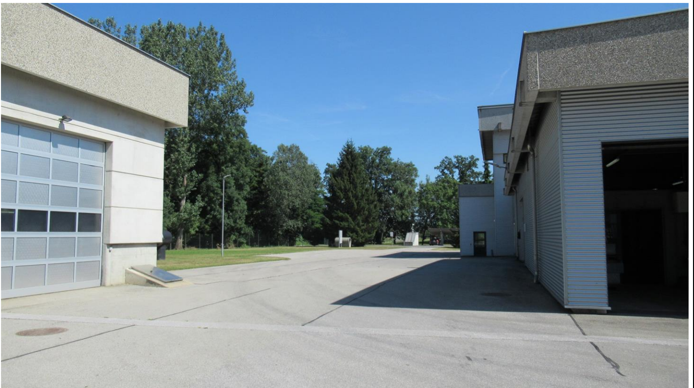
Betriebliche Verkehrsflächen bei mechanischer Reinigungsstufe (Blickrichtung Südosten)
