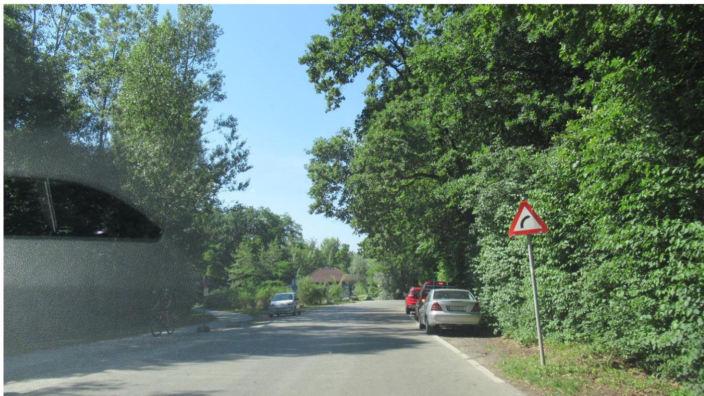
Kanalweg (km 2,0) - Parkende KFZ am Straßenrand - Beschilderung Gefährliche Kurve (Blickrichtung Nordwesten)
