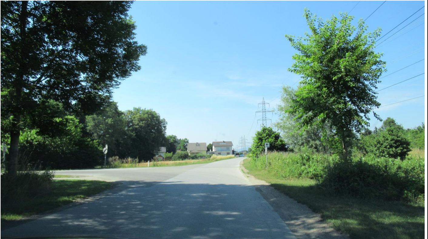
T-Kreuzung Sportplatzstraße (km 0,8) - Kanalweg (Blickrichtung Norden)
