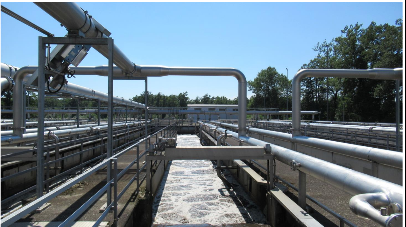
Bestehendes Belebungsbecken 2 (Blickrichtung Südwesten)
