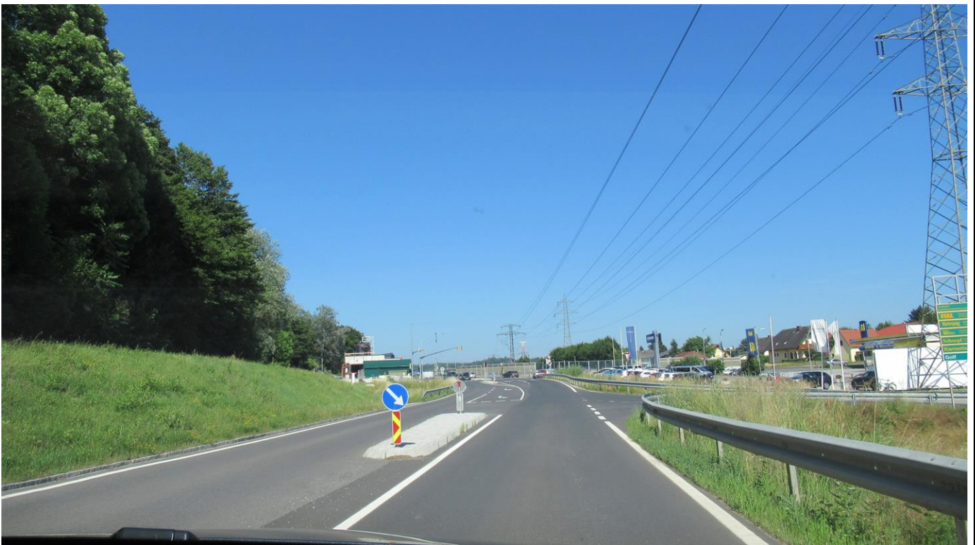
T-Kreuzung Liebenauer Tangente (ca. 0,6 km nach Kurve Kanalweg) - Golfstraße (Blickrichtung Westen)
