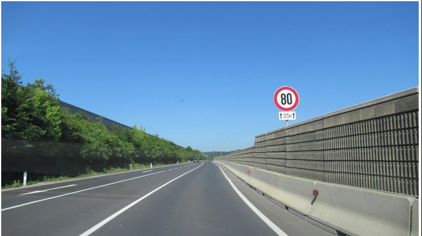
L390 Grambacherstraße (km 2,4) - Geschwindigkeitsbeschränkung Max. 80 km/h auf den nächsten 1.275 m (Blickrichtung Nordwesten)
