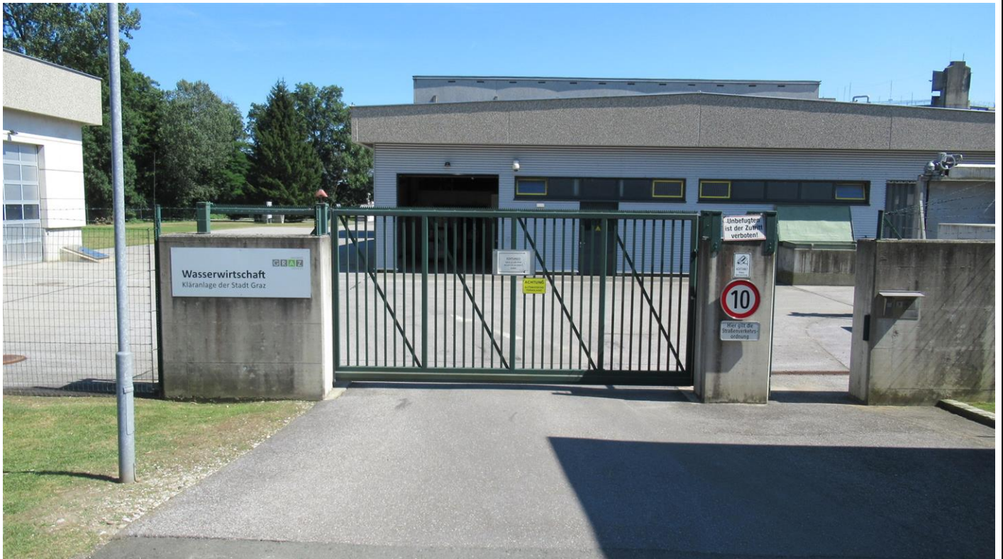
Nördliches Einfahrtstor (Blickrichtung Südosten)
