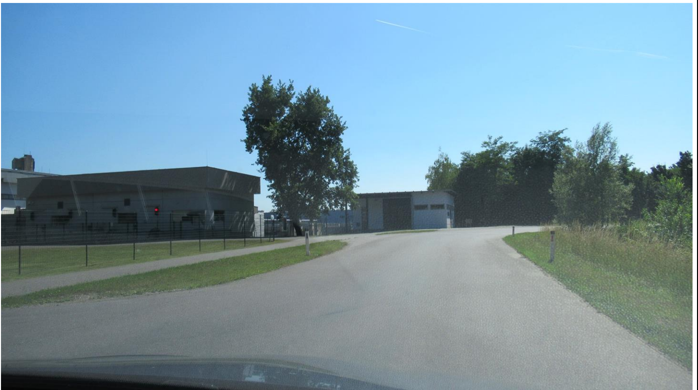
Kanalweg (km 0,1), im Hintergrund nördliches Einfahrtstor (Blickrichtung Südwesten)
