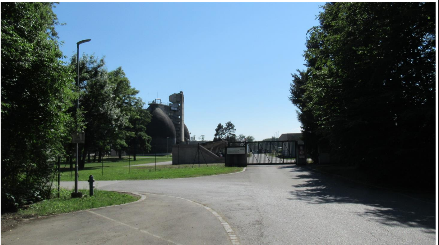
Haupttor, links Zufahrtsstraße zu östlichem und südlichem Einfahrtstor (Blickrichtung Südwesten)
