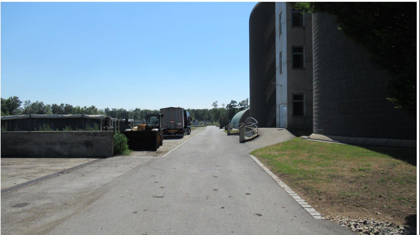
Betriebsinterne Zufahrtsstraße bei Schlammbehandlung (Blickrichtung Südwesten)
