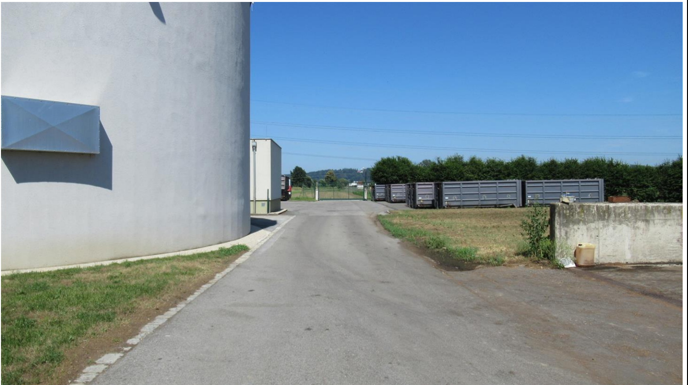
Betriebsinterne Zufahrtsstraße bei Schlammbehandlung, im Hintergrund östliches Einfahrtstor (Blickrichtung Nordosten)
