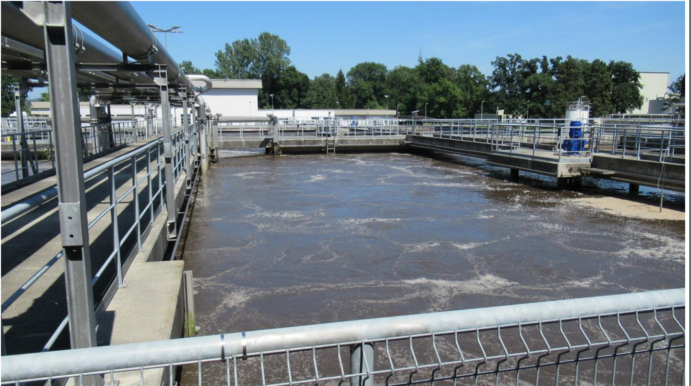
Bestehendes Belebungsbecken 1 (Blickrichtung Nordosten)
