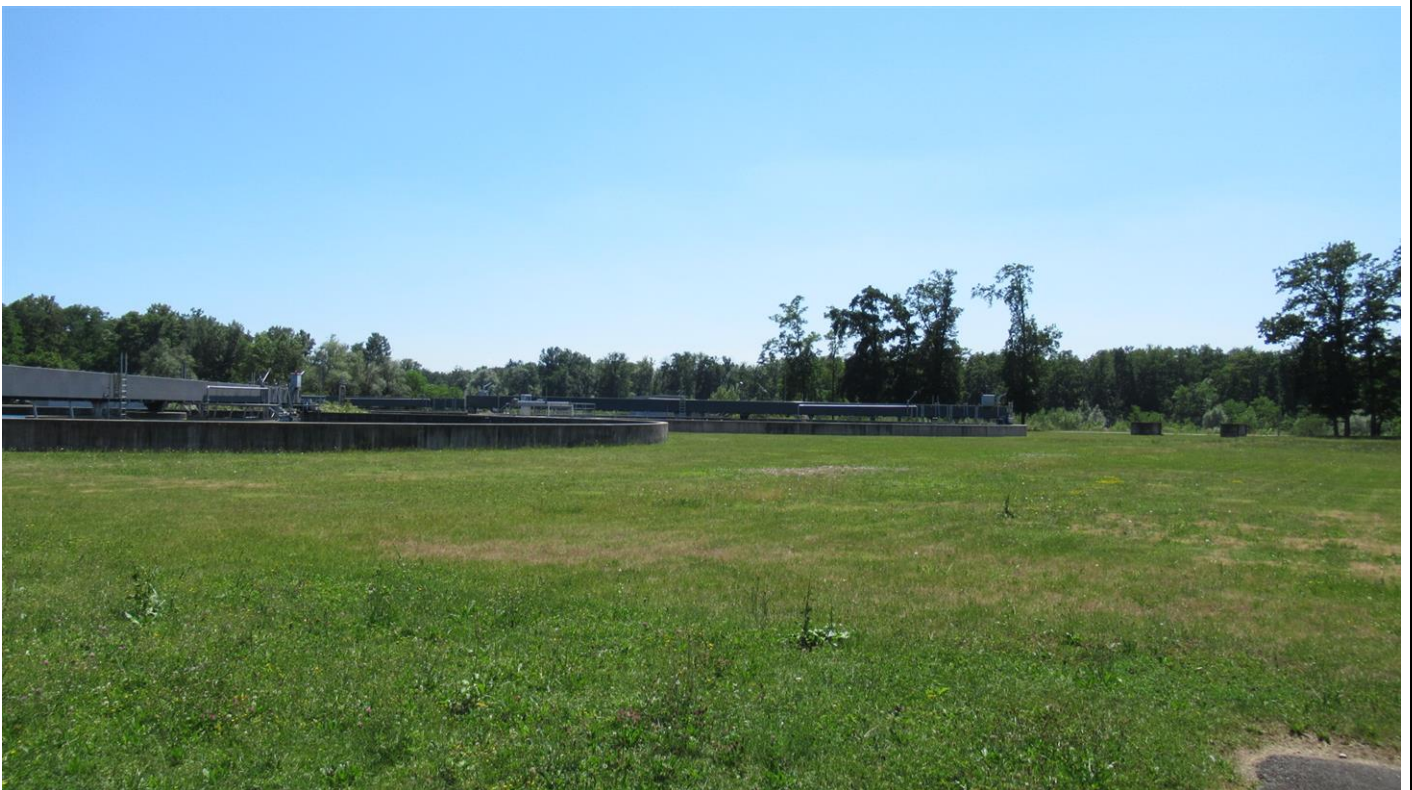
Lage des geplanten Belebungsbeckens, links bestehende Nachklärbecken (Blickrichtung Süden)
