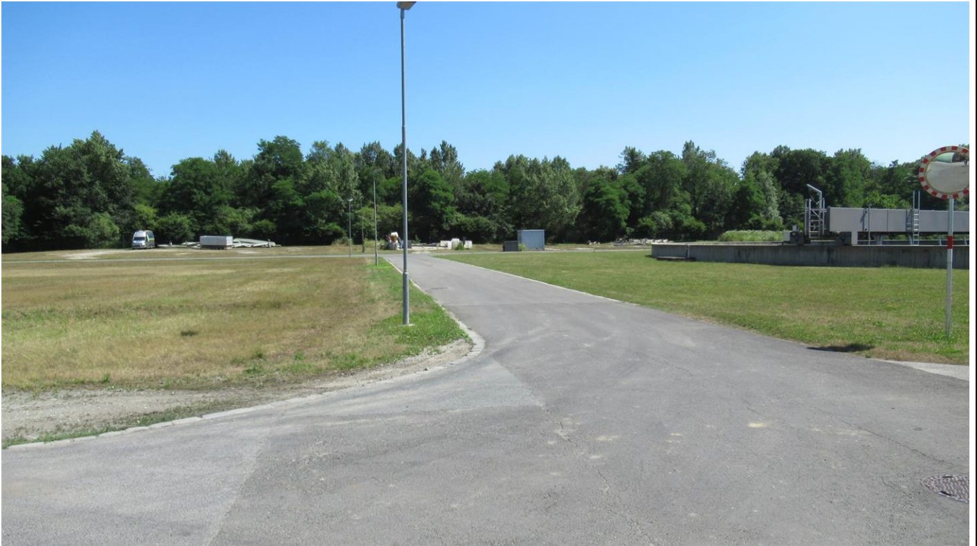
Betriebsinterne Zufahrtsstraße, rechts Nachklärbecken (Blickrichtung Südosten)
