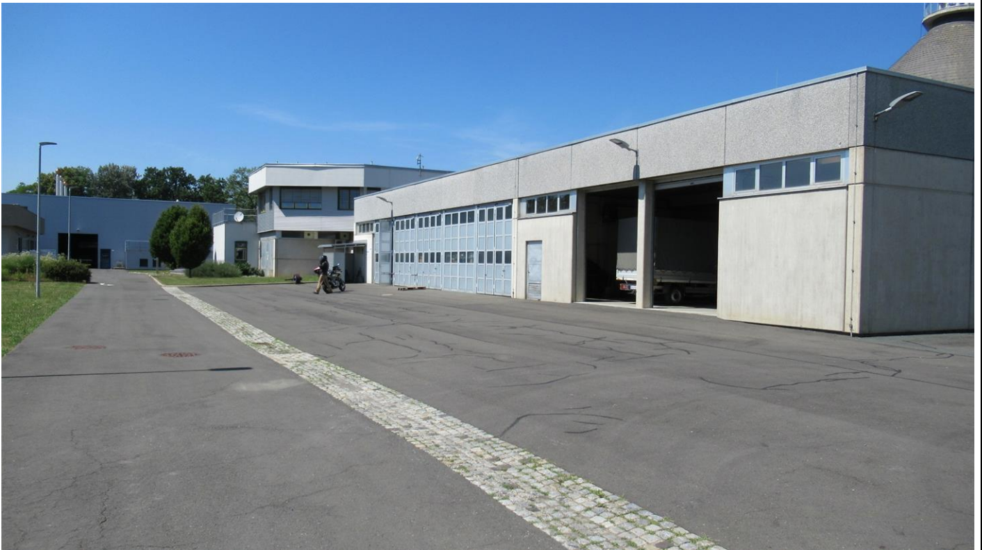
Betriebsinterne Zufahrtsstraße bei geplantem Belebungsbecken (Blickrichtung Nordosten)
