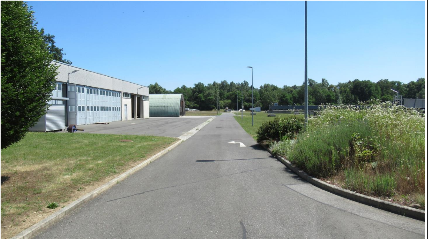
Betriebsinterne Zufahrtstraße bei geplantem Belebungsbecken (Blickrichtung Südosten)
