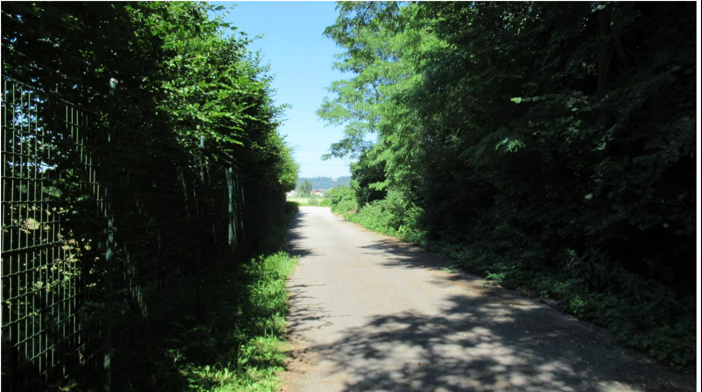
Zufahrtsstraße zum südlichen Einfahrtstor (Blickrichtung Nordosten)
