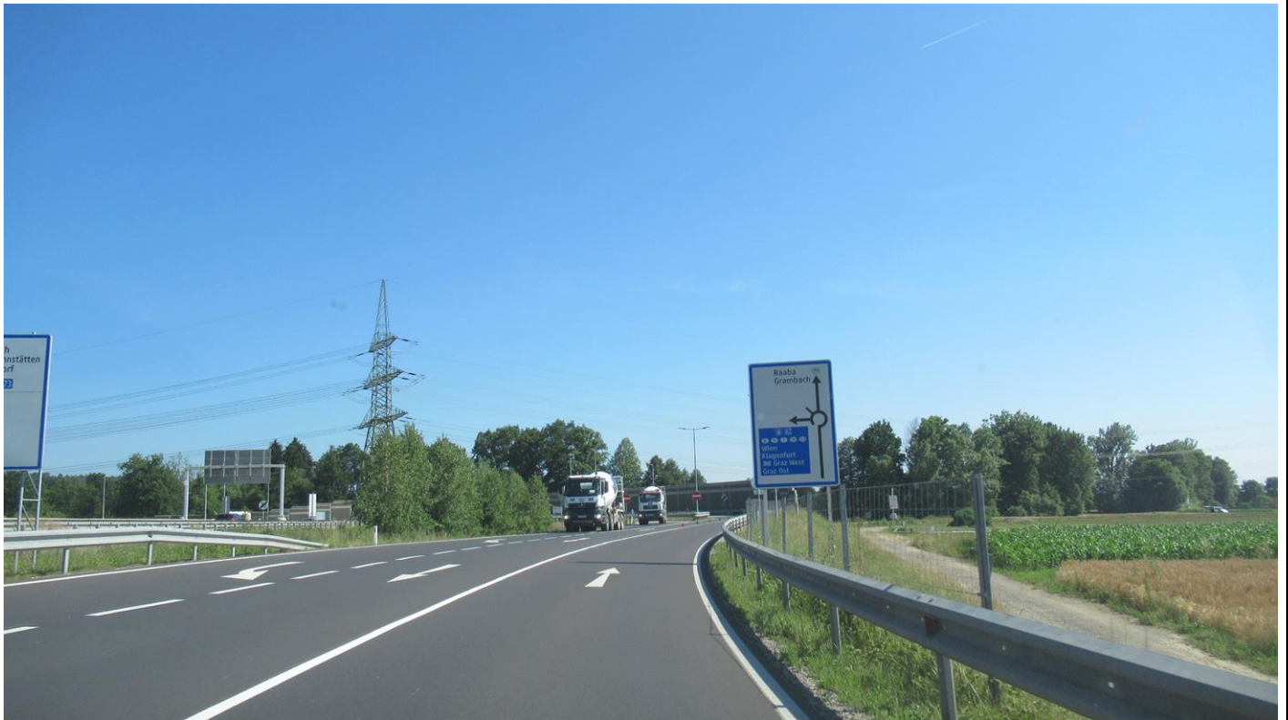
L390 Grambacherstraße (km 1,4) - Beschilderung Kreisverkehr mit Ausfahrten Richtung Raaba/Grambach und Auffahrt auf die A2 (Blickrichtung Südosten)
