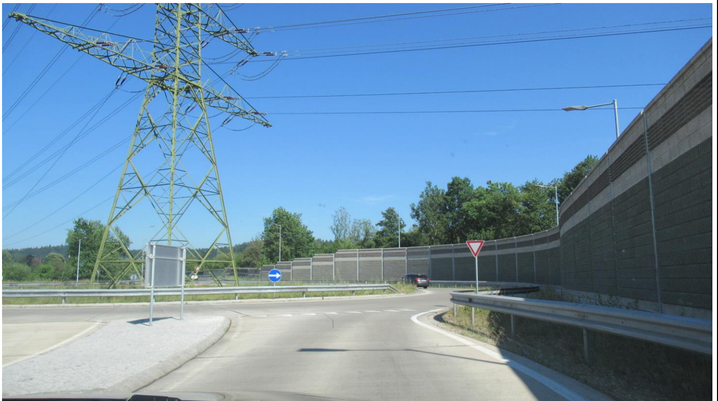
L390 Grambacherstraße (km 1,2) - Zufahrt zu Kreisverkehr (Blickrichtung Westen)
