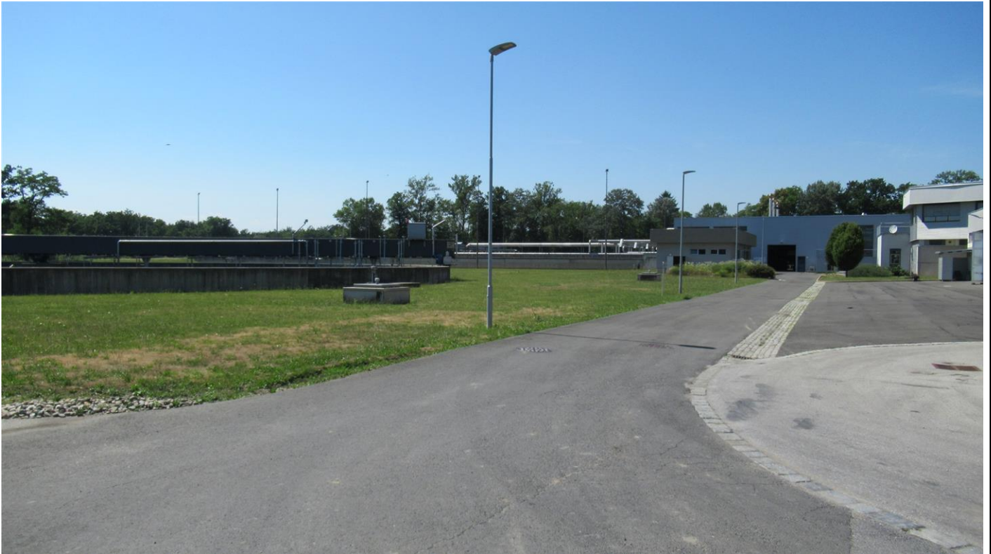
Betriebsinterne Zufahrtsstraße bei Nachklärbecken, im Hintergrund Lage des geplanten Belebungsbeckens (Blickrichtung Nordwesten)
