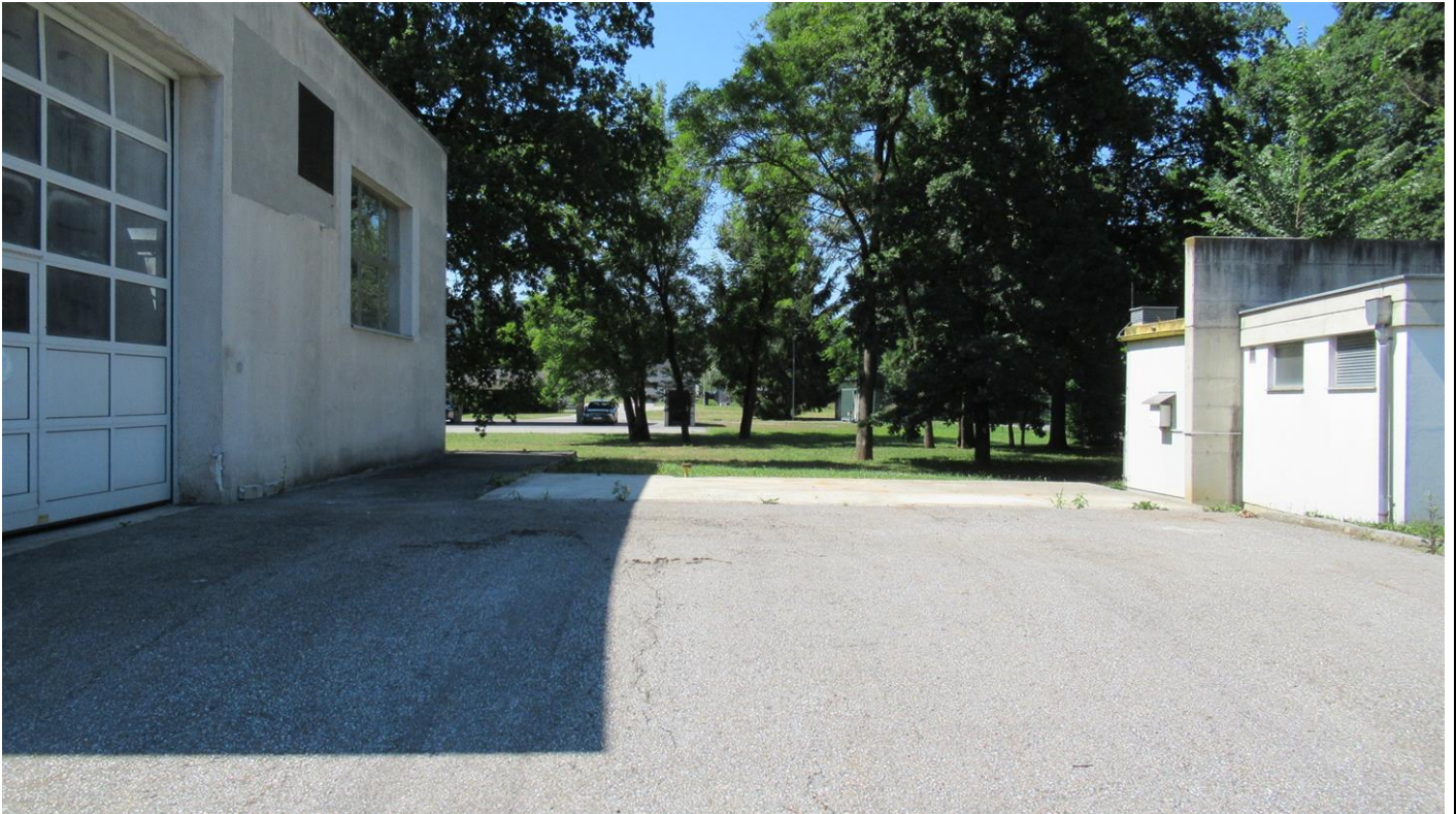
Betriebliche Verkehrsflächen bei Schlammbehandlung (Blickrichtung Nordwesten)
