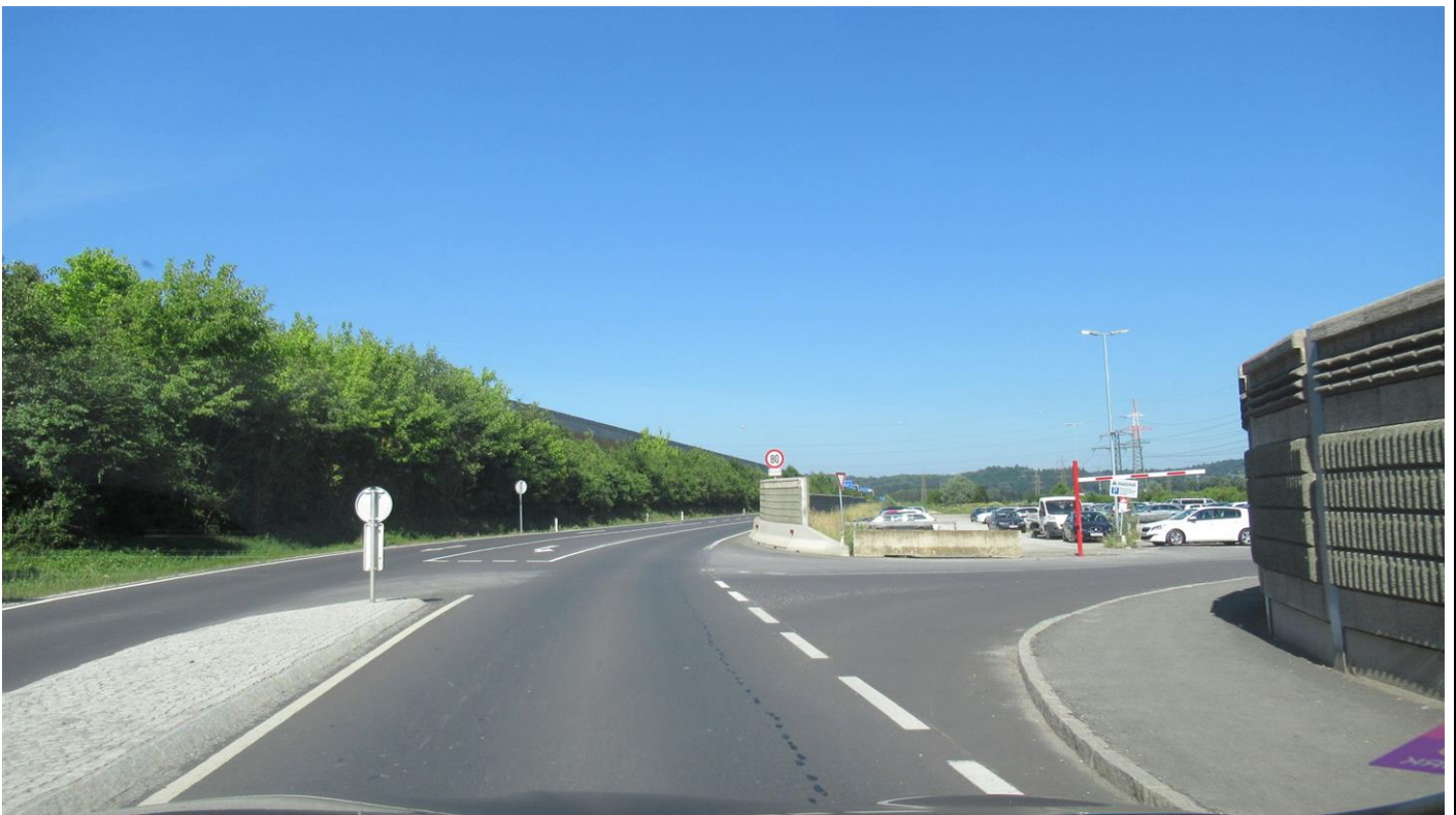
L390 Grambacherstraße (km 2,4) - Einfahrt zu Magna Parkplatz (Blickrichtung Nordwesten)
