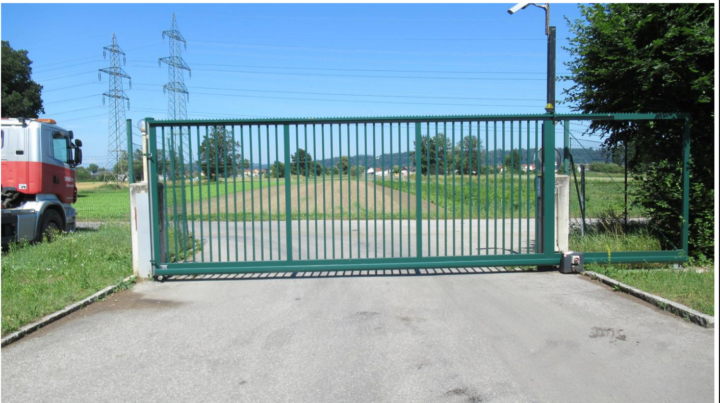
Östliches Einfahrtstor bei Schlammbehandlung (Blickrichtung Nordosten)
