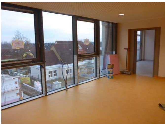
Ausblick Stiegenhaus im Zubau (Obergeschoß)
