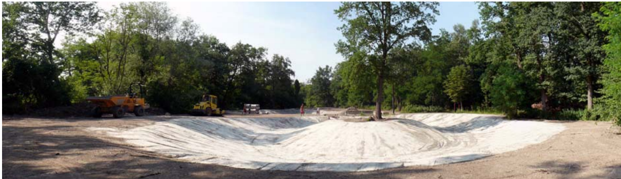
Foto 1: Künstliche Teichabdichtung während der Bauphase
